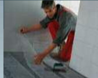
4. Smeer de tegellijm uit met een lijmkan van 3 tot 4 mm en leg de verwarmingsmatten in de tegellijm.
