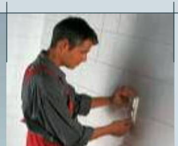
8. Elektrisch aansluiten van het vloerverwarmingsstelsel.
