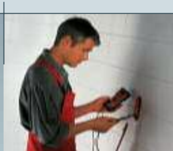
7. Gedurende de gehele installatie moet de weerstand van de draden (ohmse waarden) doorgemeten en gecontroleerd worden.
