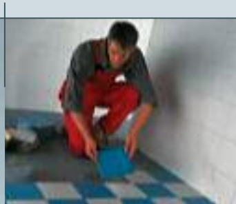
6. Uitsmeren van de tegelijm en het zetten van de tegels.
