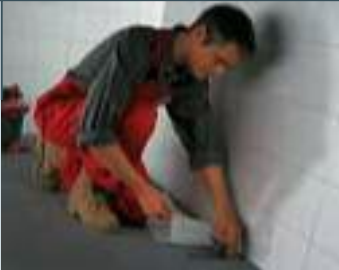
1. Leg de temperatuurvoeler aan. Let Op! De voeler en aansluitkabel niet samen in
